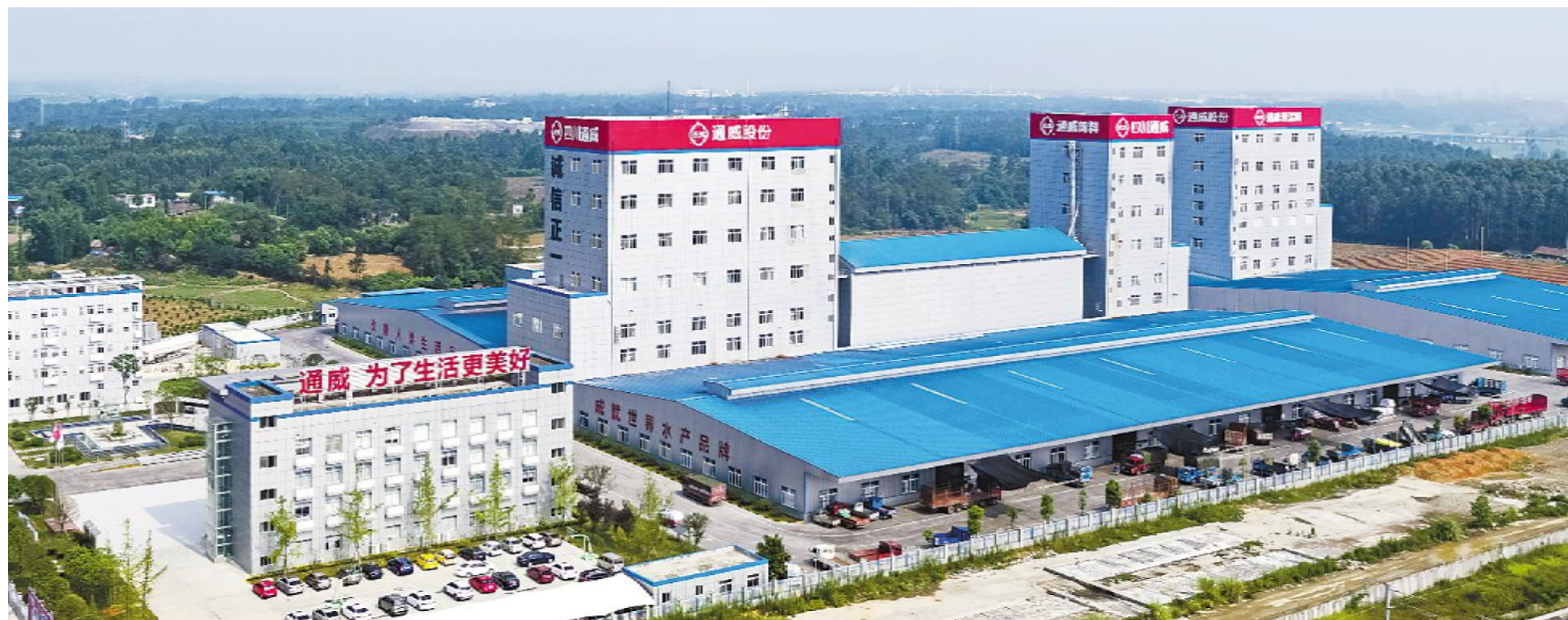
通威饲料现代化生产基地
